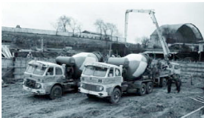
1975. Bombeando hormigón para formar los muros de la piscina olímpica -que sustituyó la original "piscina de mujeres"- y que hoy contienen la piscina familiar.
